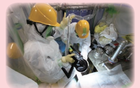
敦賀発電所1号機 排水ピットの除染工事
