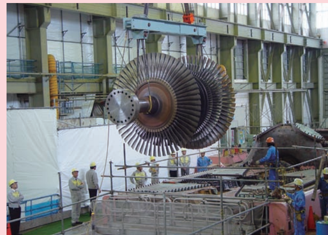
東海発電所 低圧タービンの撤去作業
