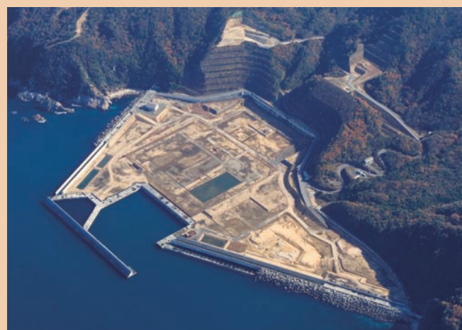
敦賀発電所3,4号機増設予定地全景
