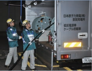
ケーブル搭載車からケーブルの引き回し夜間訓練
