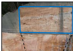
D-1 トレンチ北西法面（実写）
