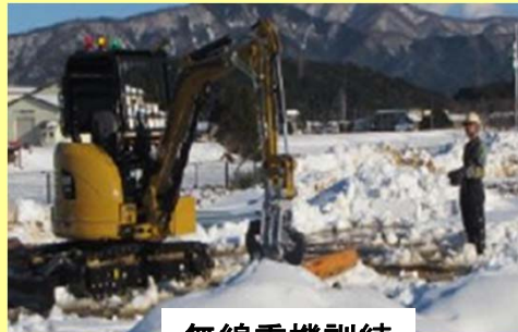
無線重機訓練
