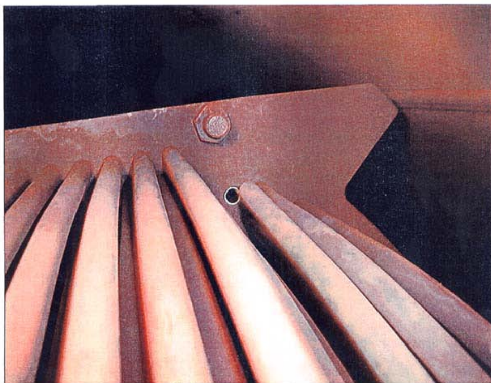
給水加熱器内部点検状況
