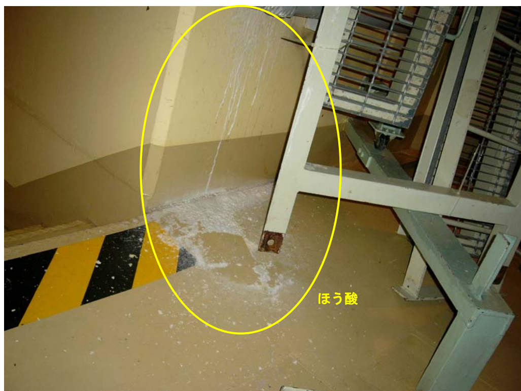
原子炉格納容器地下2階床面
