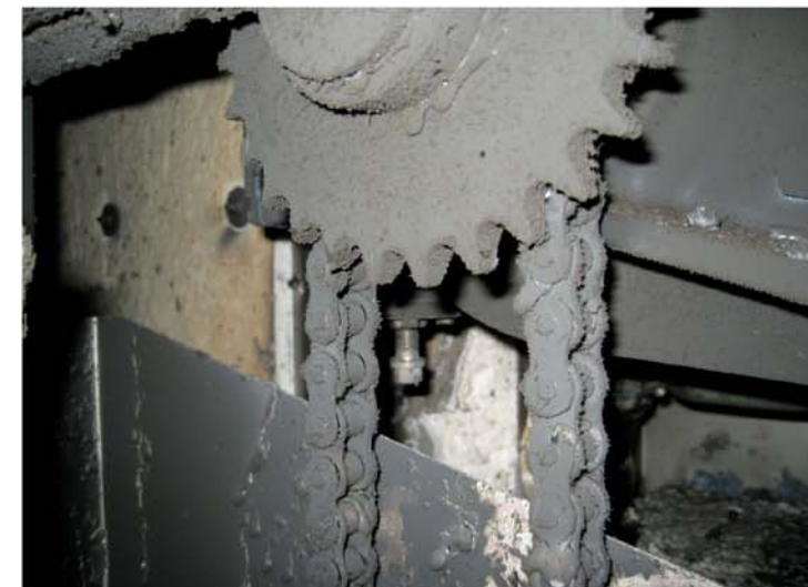
昇降機駆動用チェーンの状況外観図
