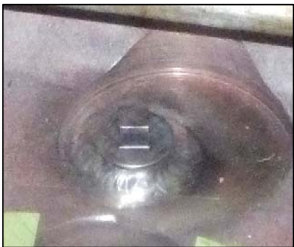
＜閉止栓対策溶接後の状況＞
