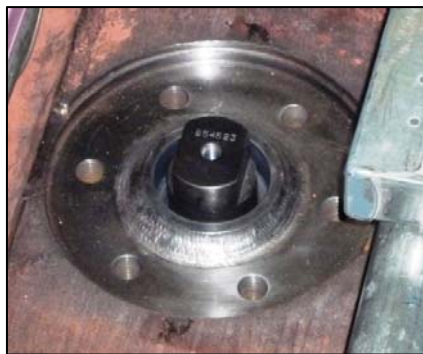
＜回り止めピン対策溶接後の状況＞
