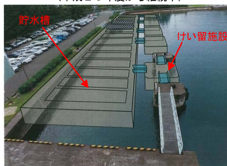
【 2号機海水貯水槽完成イメージ図 】 (平成20年度から継続中)
