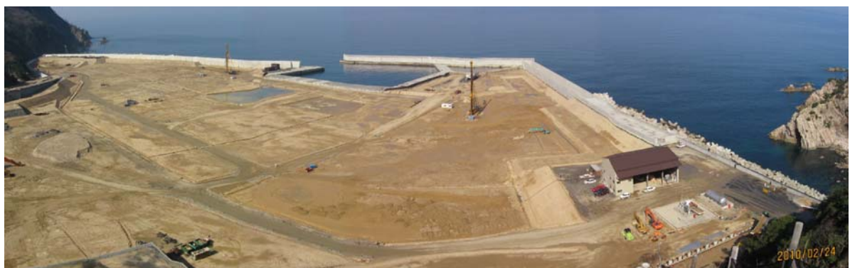
防波堤・護岸及び埋立の状況 （平成22年2月撮影）
