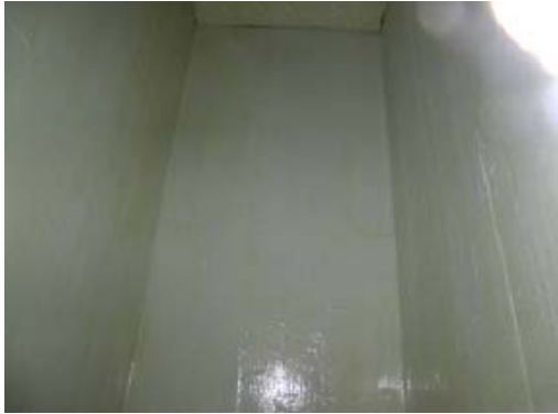
バルブチャンバ室壁面 (ライニング損傷なし)
