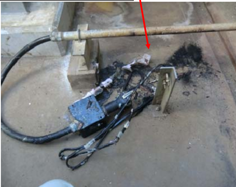
凍結防止用ヒーター(被覆部の焦げ痕)
