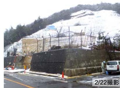
D-1 トレンチ部 掘削状況
