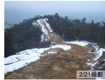
f-25 トレンチ部 掘削状況
