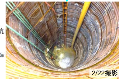
D-5 大深度坑立坑内 (横坑部掘削状況)
