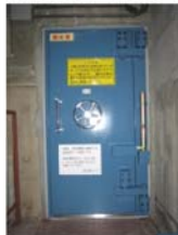
水密扉の設置
