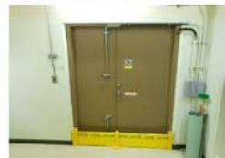
浸水防止堰の設置
