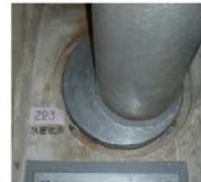
貫通部の止水処理
