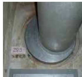
貫通部の止水処理(例)
