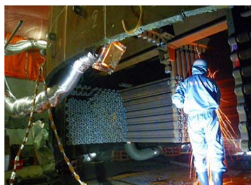
内部構造物（伝熱管）切断状況
