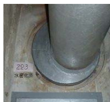
貫通部の止水処置(例)
