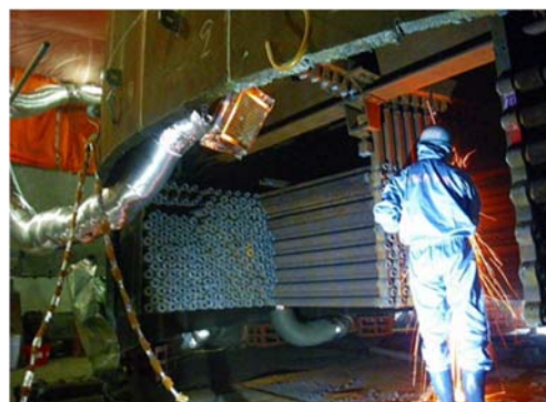
内部構造物(伝熱管)切断状況
