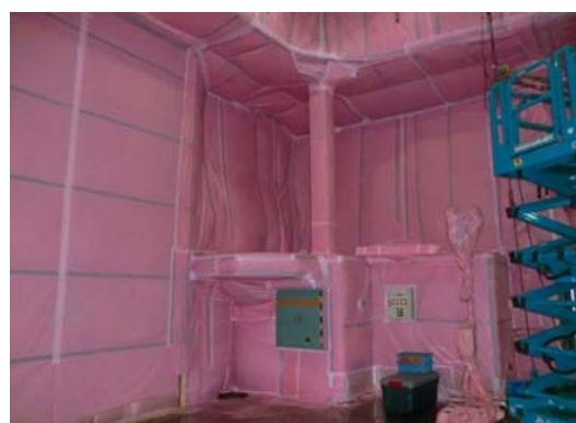
1号熱交換器撤去後 壁面清掃状況
