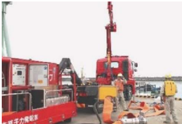
ポンプ車を使った 海水取水訓練
