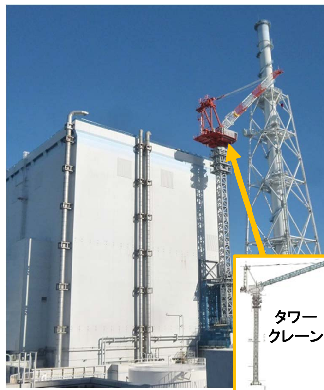
タワークレーン設置
