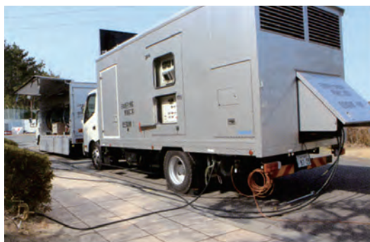
[電源容量: 500kVA(1台)×4台]
