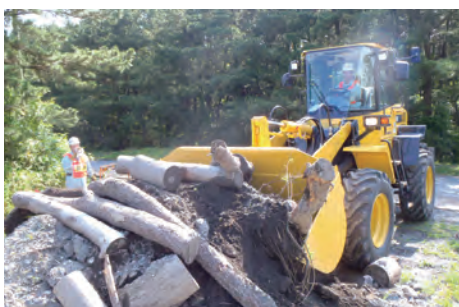
重機(ホイールローダ)を使った 障害物撤去訓練
