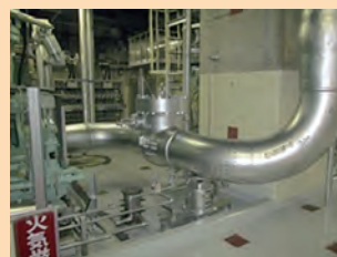
復水配管点検
