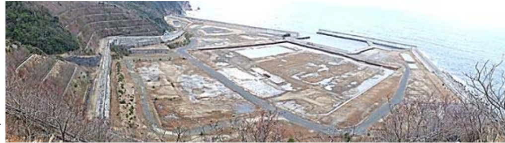
建設予定地の状況▶ (2021年12月23日撮影)
