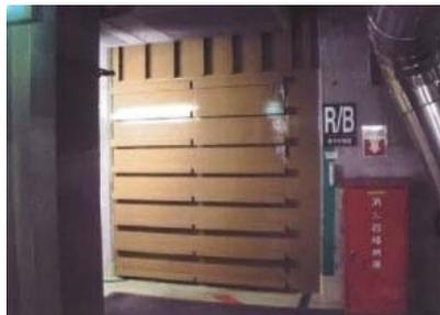
【原子炉建屋地下階扉への閉止板の設置状況】
