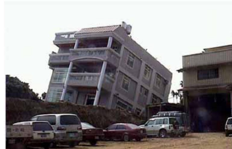
地表断層直上のRC造建物 (傾斜による被害) 豊原市中正公園付近の建物
