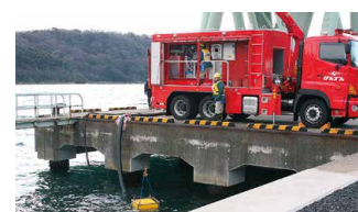
冷却水確保訓練
