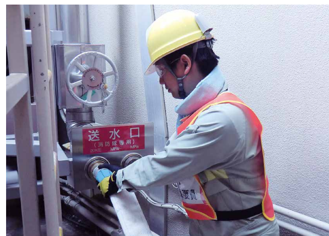
専用配管へのホースつなぎ込み訓練
