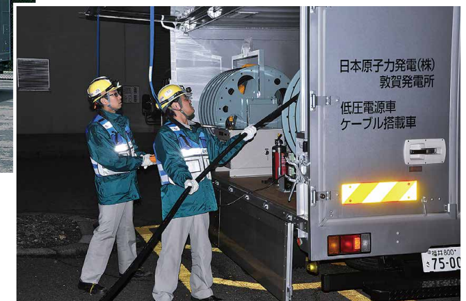
ケーブル敷設訓練の様子
