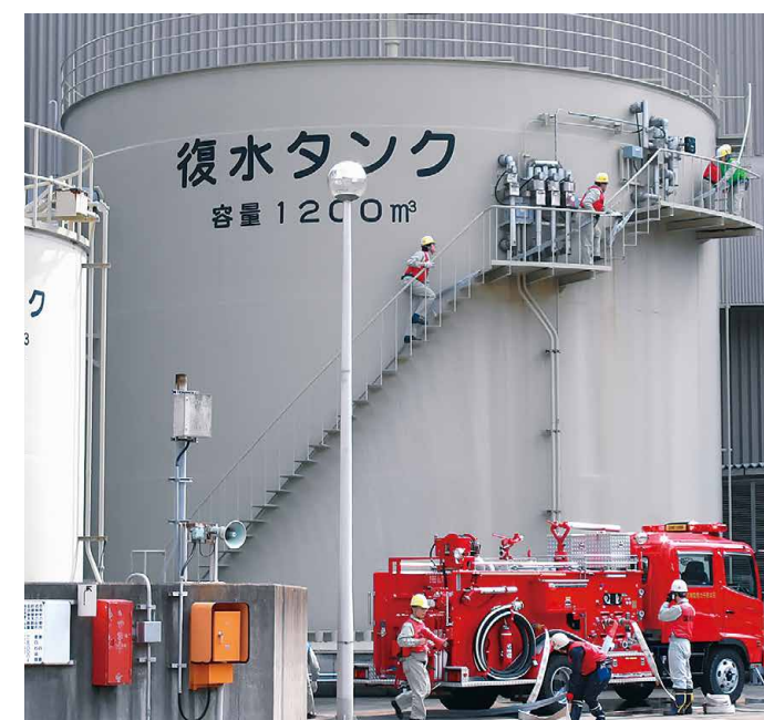
復水タンクへの給水訓練
