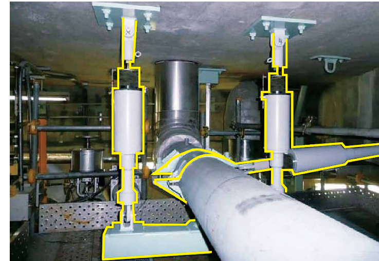
原子炉建屋内の重要配管へのサポート設置（例）
