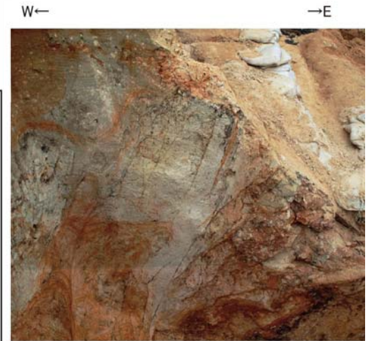
2-1トレンチ北面写真
