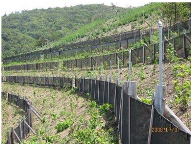
■ 緑化前の切取法面(2008年7月撮影)
