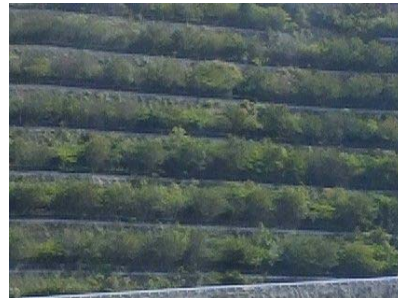
■ 緑化後の切取法面(2018年10月撮影)
