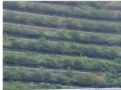
■ 緑化後の切取法面(2019年9月撮影)
