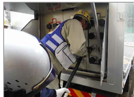
電源車に供給用ケーブルを接続
