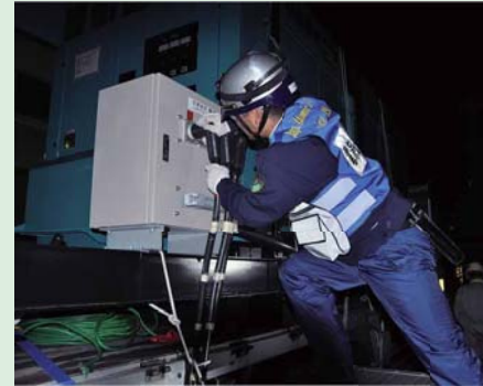
所内電源盤への電源ケーブル接続訓練(夜間訓練)
