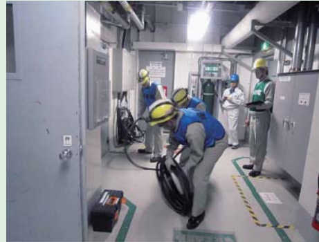
所内電源盤までの電源ケーブル敷設訓練
