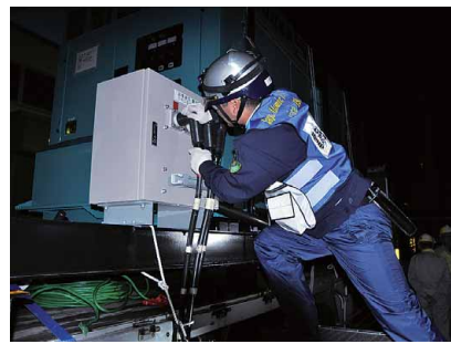
夜間のケーブル接続訓練
