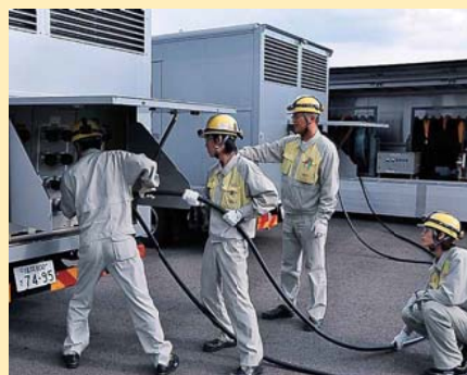
低圧電源車から配電盤への電源ケーブルのつなぎ込み
