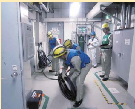
所内電源盤への電源ケーブルの引き回し
