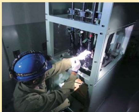
照明が無い状態を想定した電源ケーブルのつなぎ込み
