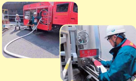
消防車を使った使用済燃料プールの専用配管への接続訓練
