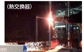
遠隔操作による熱交換器の切断・解体作業 （2010年8月）
