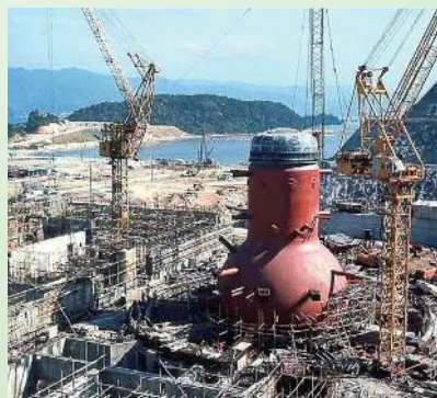
▲建設に着手(第一回工事計画認可) 1967年2月27日
