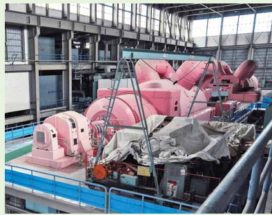
撤去前のタービン発電機 （平成15年4月撮影）
