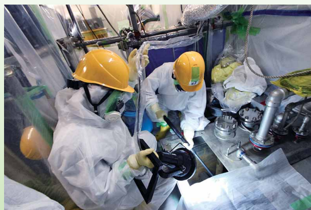
安全対策を講じた上で排水ピット内の除染作業を実施
