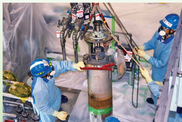
除染作業エリア内の機器（ポンプ）の取り外し作業を実施
