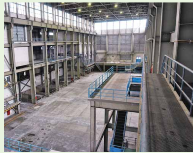
タービン建屋内機器撤去後 （平成16年3月撮影）
