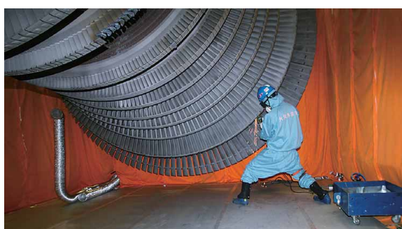
タービンの羽根車の解体を行っています
