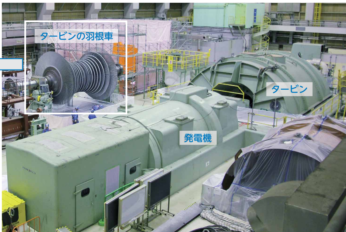
タービン・発電機解体工事
