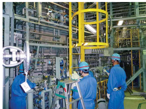
原子炉の出力を調整する制御棒を動かす装置の解体を行っています
