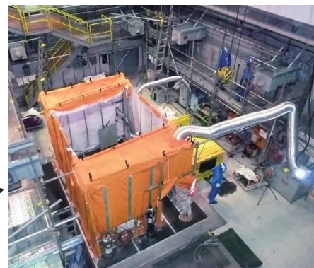
細断ハウスの設営等を行い、機械工作室内部機器の解体作業を行っています
