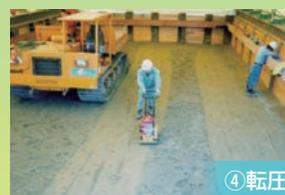
覆土した後、転圧(機械で土を固める)
