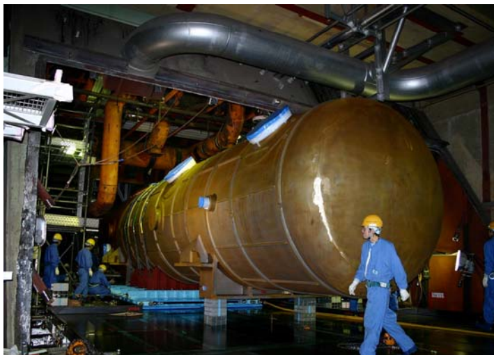
第6給水加熱器取替工事 新加熱器搬入の様子
