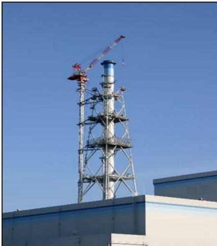
主排気筒補強工事の様子
