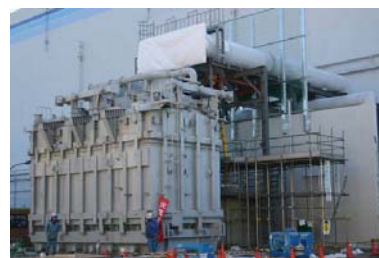
主変圧器撤去作業状況
