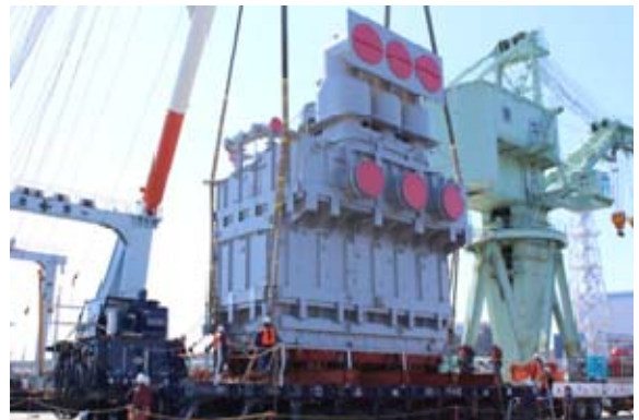
新変圧器搬入作業状況 （写真は東海港からの荷揚げの状況）
