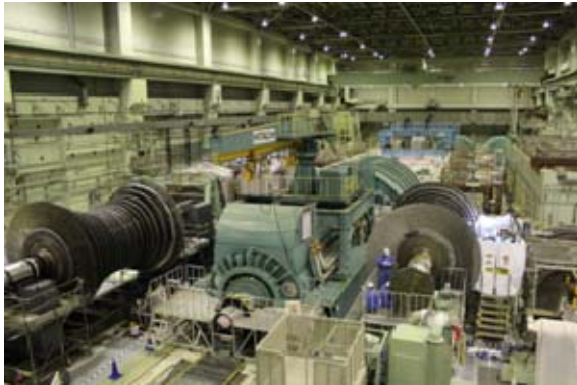
タービン建屋3階 3月2日現在の状況
