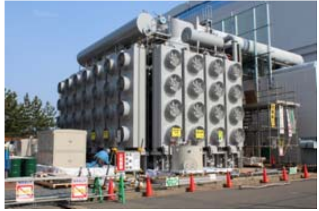
新変圧器据付作業状況
