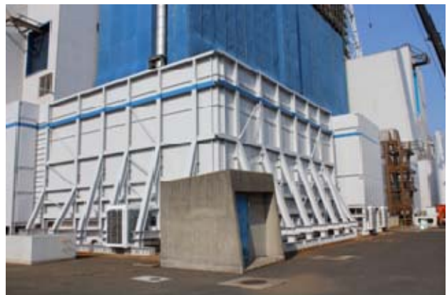
非常用ディーゼル発電機室 の防護壁設置状況
