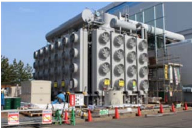
新変圧器据付作業状況
