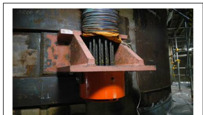
【吊り具取り付け状況】
