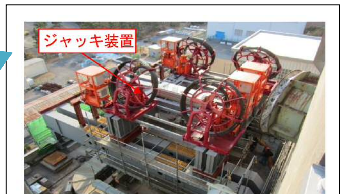
【ジャッキ装置取り付け状況】
