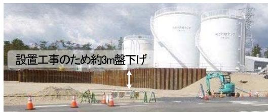
設置工事のため約3m盤下げ
