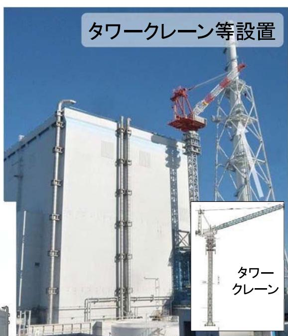
原子炉建屋周囲工事用重機の設置
