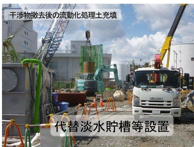
干渉物撤去後の流動化処理土充填
