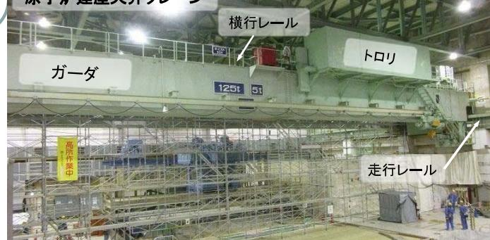
原子炉建屋天井クレーン 耐震補強
