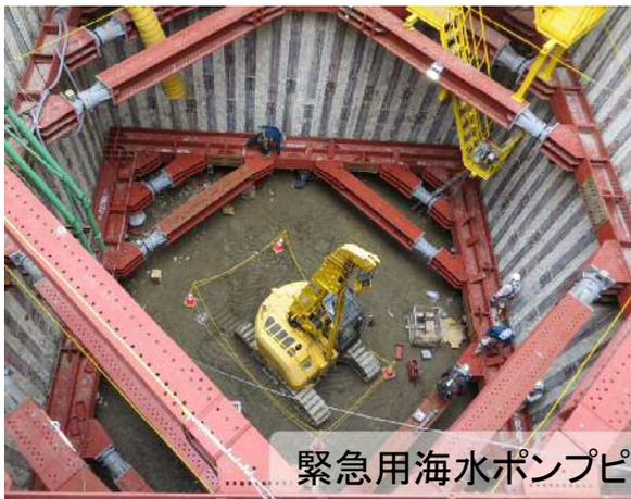
緊急用海水ポンプピット設置のための掘削
