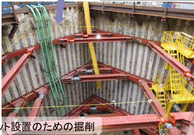
○鋼管杭打設, 鋼製桁設置
