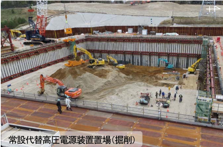
常設代替高圧電源装置及び同置場
