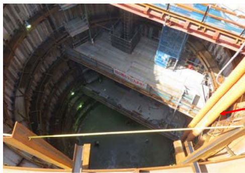
SA用海水ピット, SA用海水ピット取水塔設置
