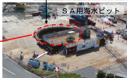
SA用海水ピット, SA用海水ピット取水塔設置
