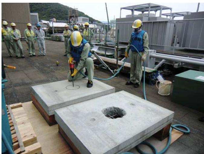
1号機原子炉建屋頂部の穴あけ模擬訓練 （６月１５日）
