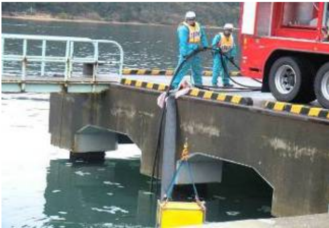
海への水中ポンプ投入状況
