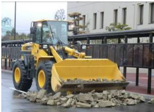
ホイールローダーによる瓦礫除去状況
