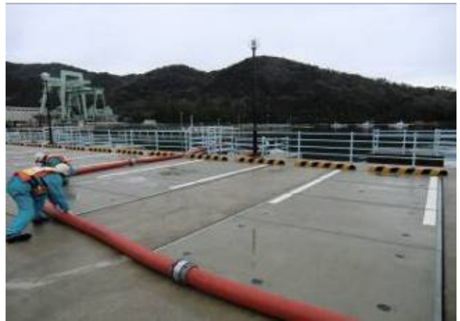
ホース接続・送水状況
